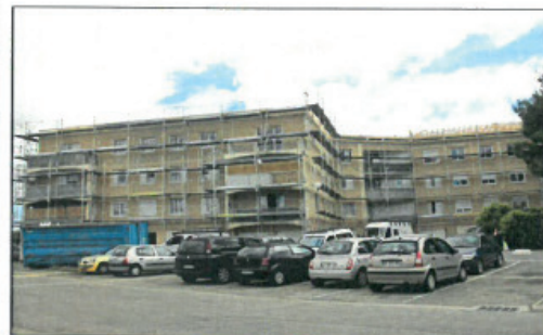
Photos du chantier
