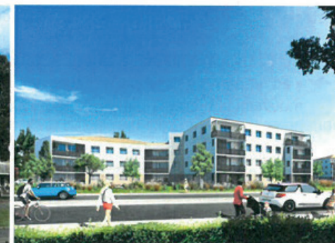
Photo après requalification
